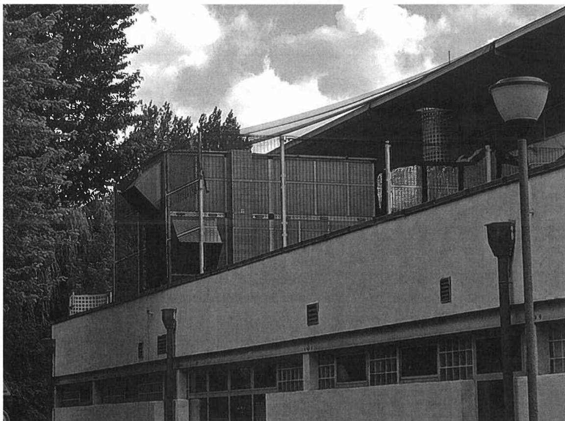
Zdj 2– widok ogólny centrali
